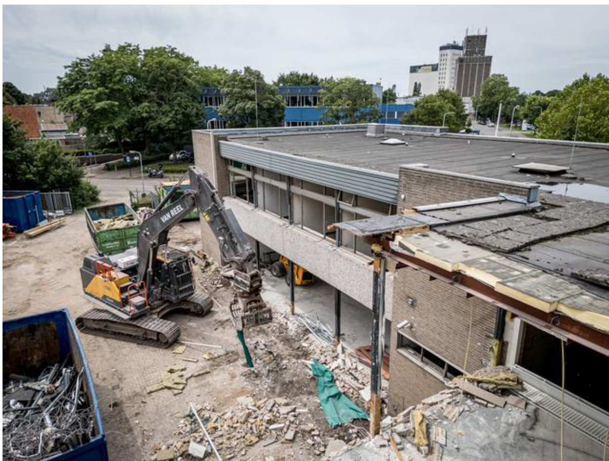
Van Reel verpulvert het oude politiebureau. Foto: Martijn Bijzitter
